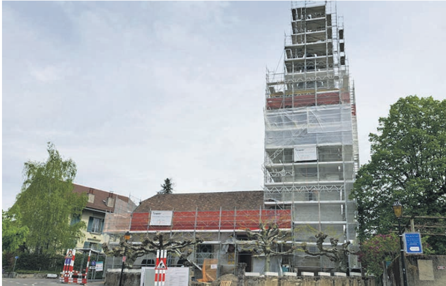
Le temple de Crissier en rénovation. © CR.
