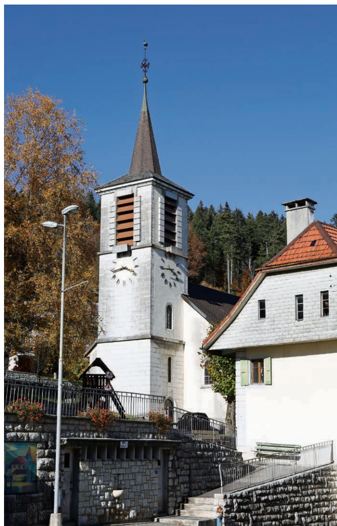
Hautes-Joux Temple des Ponts-de-Martel
